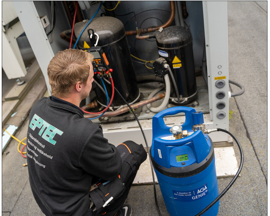
Eirik Hellerud, har lenge jobbet med å lekkasjesjekke og trykkteste kulde- og varmepumpeanlegg i Oslo-området. Han har kjent på kroppen hvor vanskelig det er med store, tunge gassflasker.
