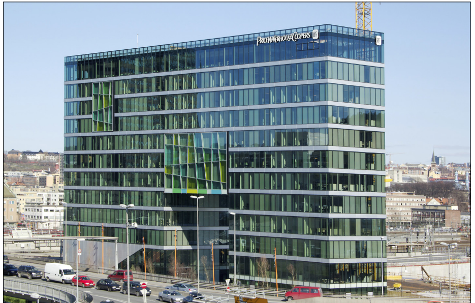
Det 12 år gamle PWC -bygget i Barcode i Bjørvika må rehabiliteres for 300 millioner kroner på grunn av høyt energiforbruk, dårlig innneklima og «støy og lekkasjer gjennom eksisterende glassfasader».
