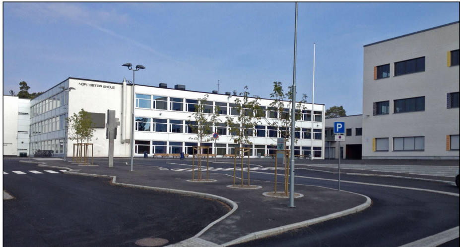
Det første prosjektet Undervisningsbygg bruker varmepumpe med propan som kuldemedium.
