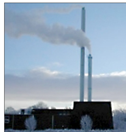
Nørre Snede Varmeværk har fået en kommunegaranti på lån til 12 millioner kroner til en 2,5MWh varmepumpe.
